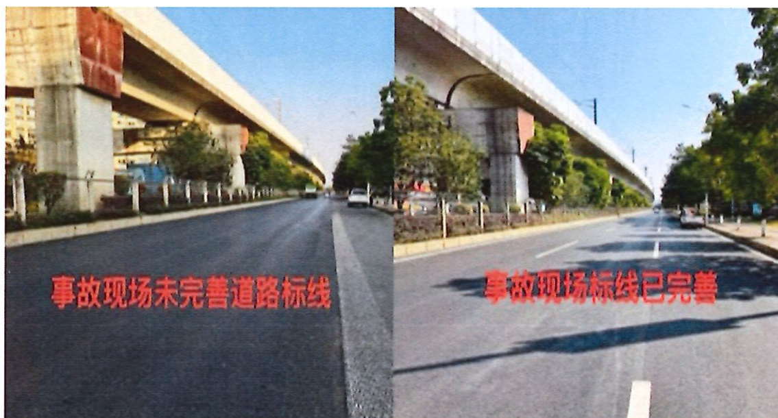
图2 事故现场整改前后对照图
