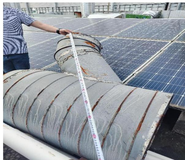
图 5 脱落的管道
