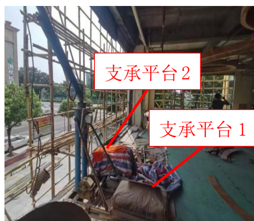
图 6 珊美社区日常安全巡查留存图片
