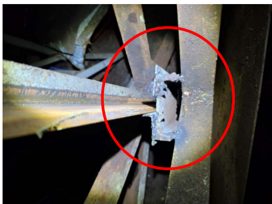
图 8 新电焊的导轨卡槽
