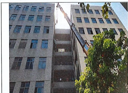
图 3 涉事吊装作业现场
