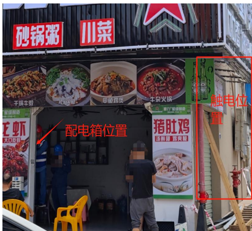
图1 控制涉事导线的配电箱位置
