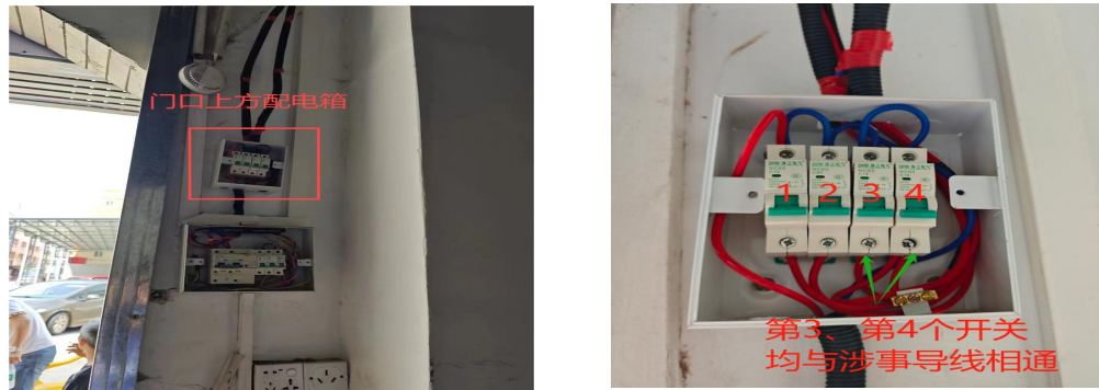
图 7 第 3、4 个开关出线与涉事导线直接相通
