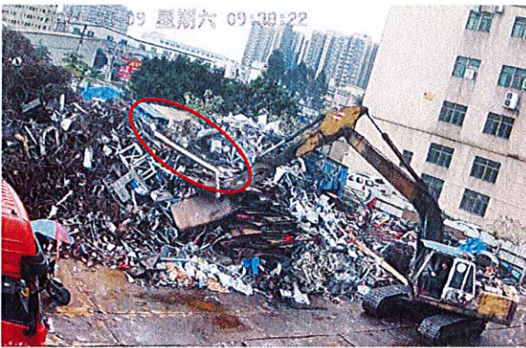
图 8 工字钢受力不均导致反转弹起
