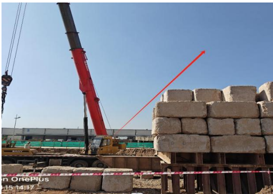
图 10 起重吊车操作室内视线
