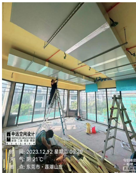
图 5 申远公司深圳分公司利用平台进行装修作业（事故前照片）
