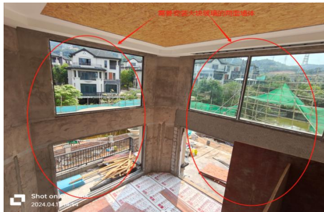
图 3 涉事别墅需安装大块玻璃的两面墙
