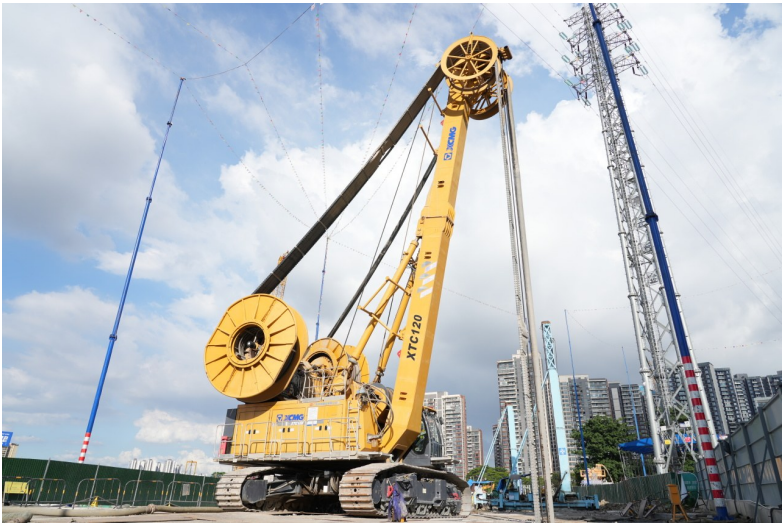
■ 工地上,大型机械在忙碌施工
