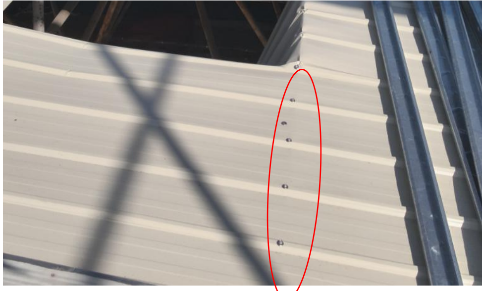
图 8 彩钢瓦上打好的固定螺丝钉
