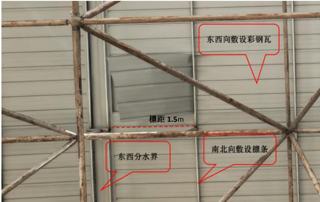
图7 涉事顶棚檩条、彩钢瓦
