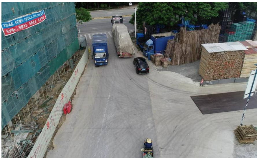
图 4-1 项目实施前现场图片
