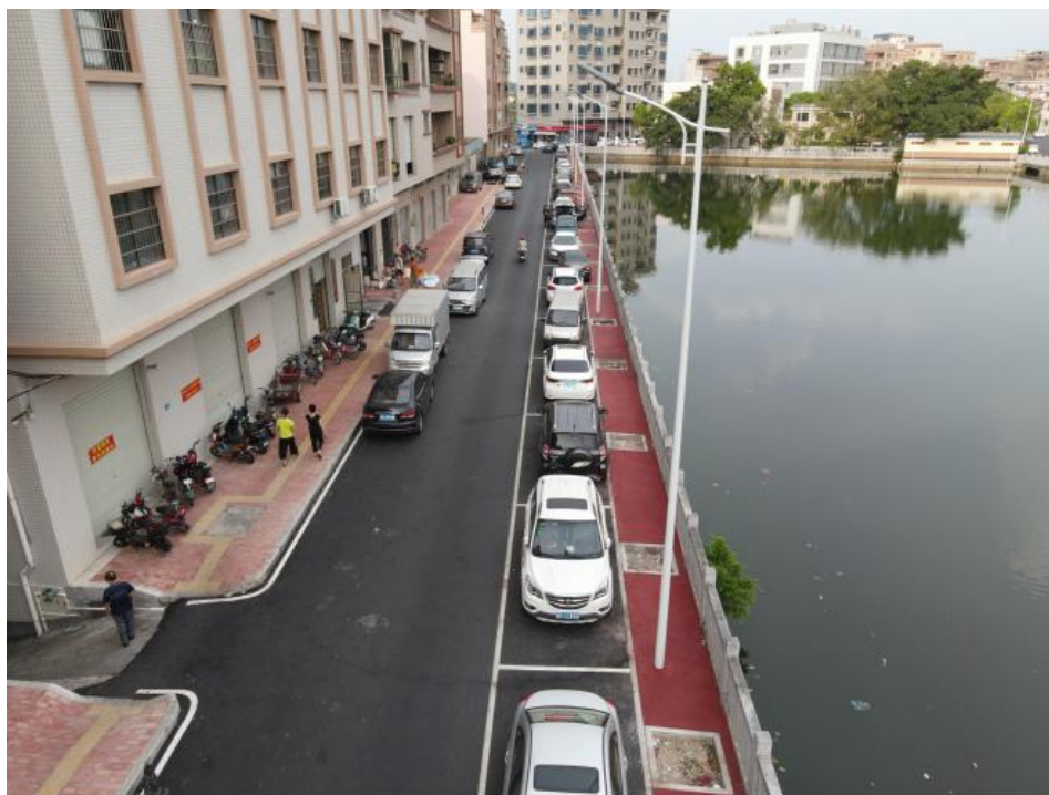
图 4-4 项目实施后现场图片
