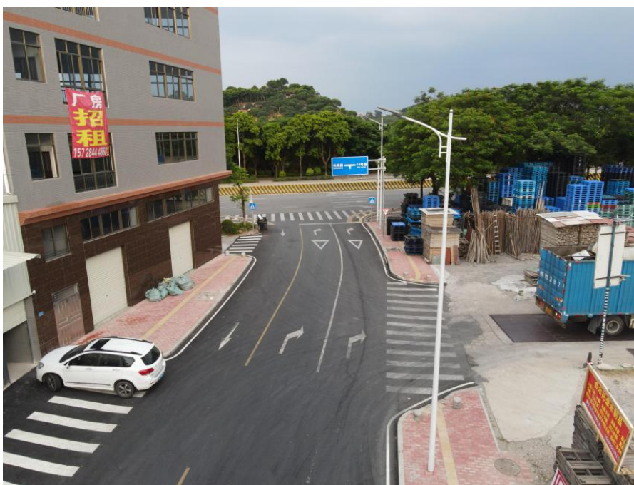
图 4-2 项目实施后现场图片
